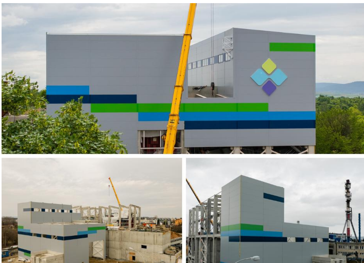
Fot. 8. Budowa bloku energetycznego opalanego pozostałościami z sortowania odpadów komunalnych na terenie Elektrociepłowni Łężańska, fot. archiwum Krośnieńskiego Holdingu Komunalnego
