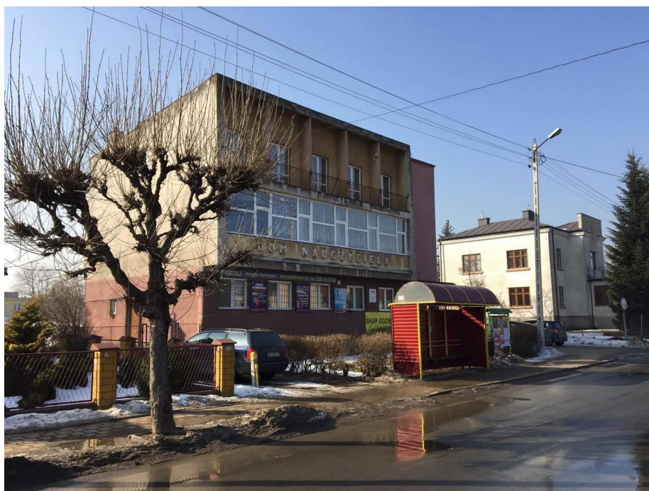
Fot. 6. Budynek „Domu nauczyciela”.
